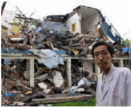
Een lid van de medische staf staat buiten een ingestort ziekenhuis in Hanwang
